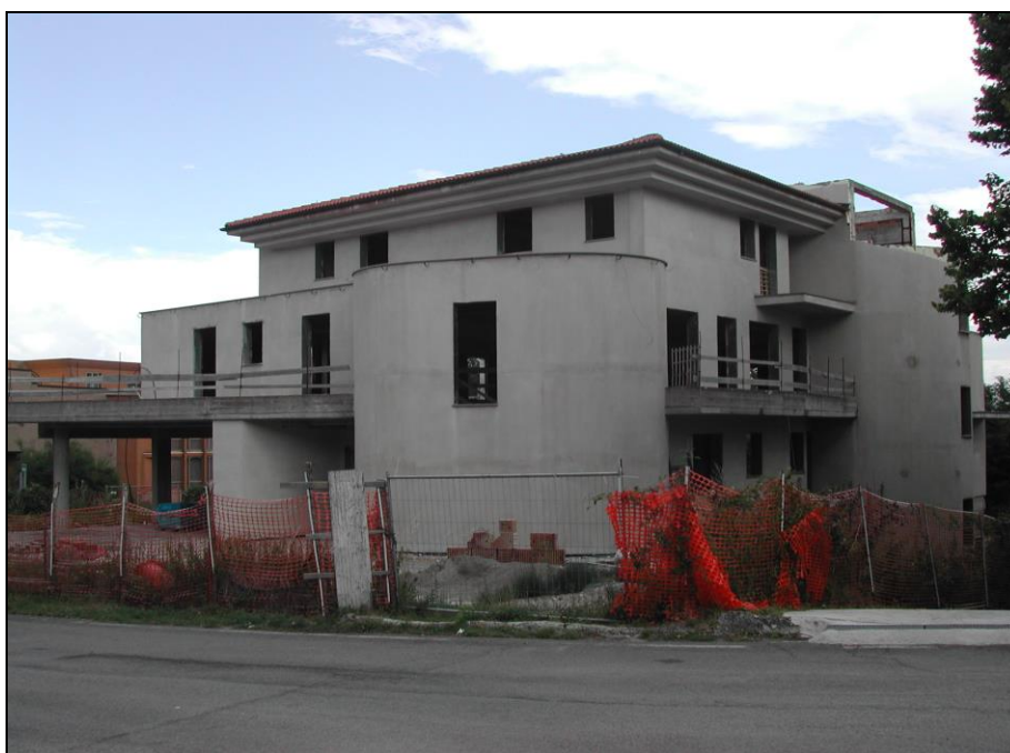
Foto 4 - Vista dalla Via G. Rossa - lati sud-est e sud-ovest
