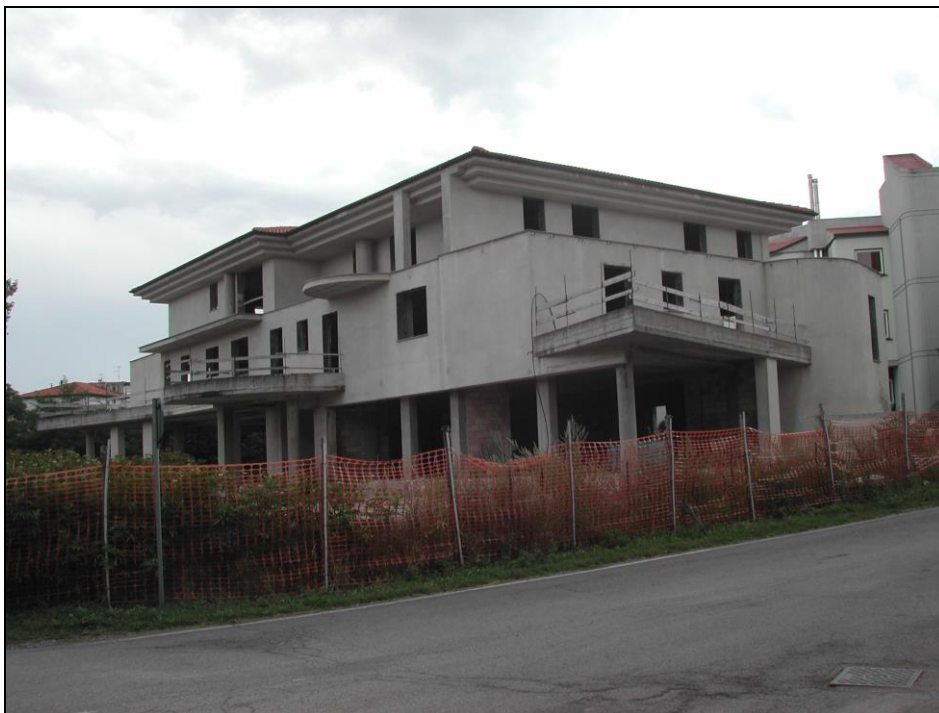
Foto 3 - Vista dalla strada provinciale - lati nord-est e nord-ovest
