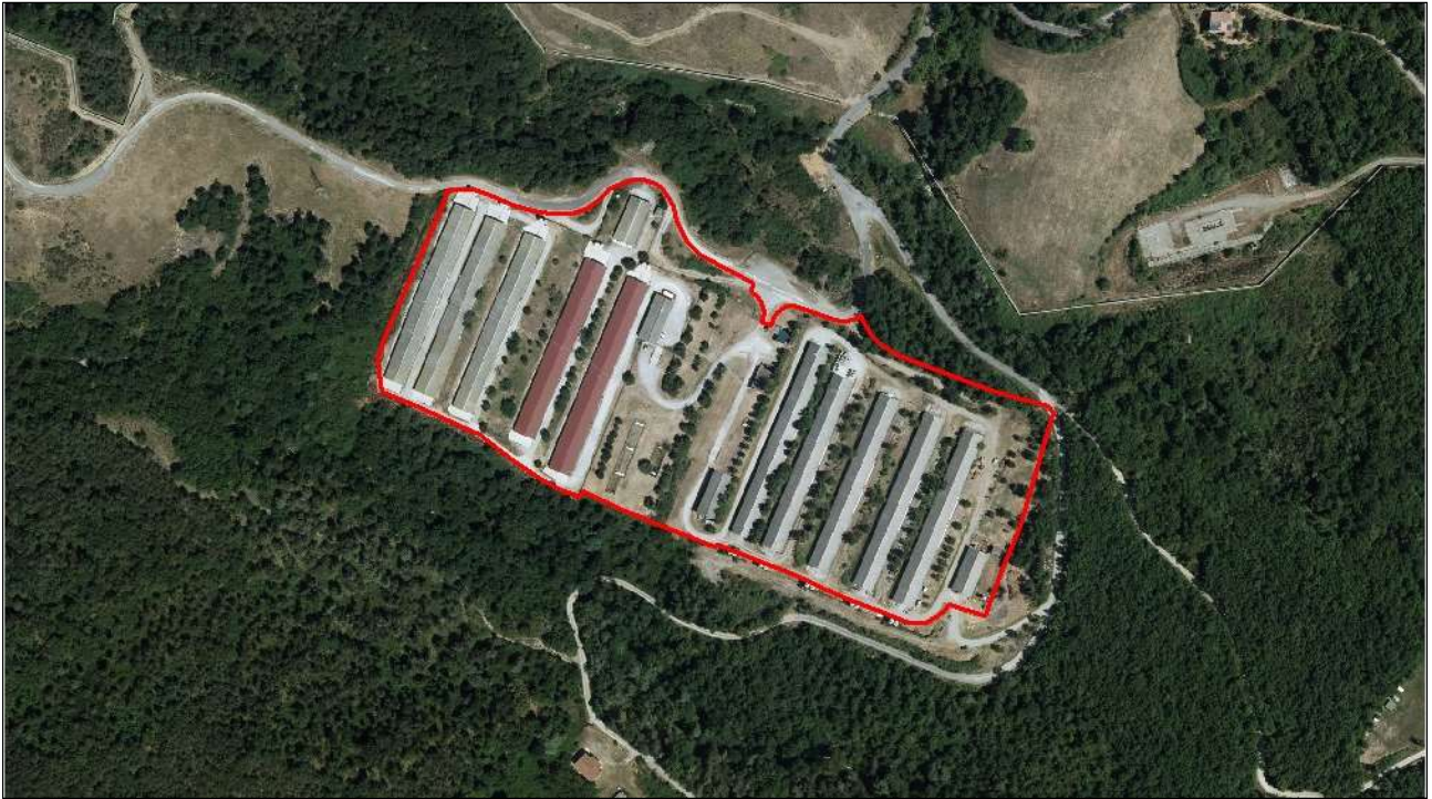
L'insediamento destinato all'allevamento intensivo di tacchini, ora utilizzato solo in minima parte. Scala 1:5.000.
